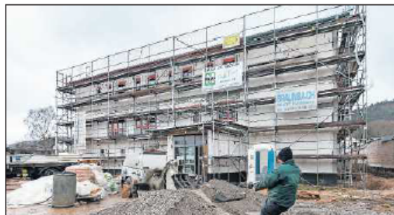
Neues Domizil eines Teils der Mitarbeiter: der Rohbau in Landstuhl. FOTO-VIEW
