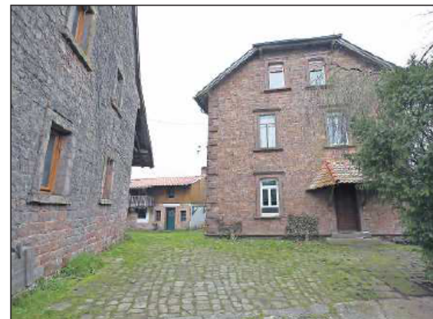
Ein Anwesen auf dem Wilensteinerhof soll eine Wohngruppe der Caritas beherbergen. Die Gemeinde unterstützt das Projekt. ARCHIVFOTO:VIEW
